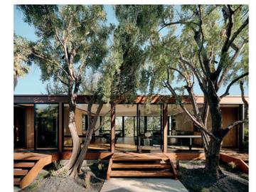
Entrée. La maison rectangulaire de plain-pied repose sur des fondations en blocs de béton avec des bases verticales des deux côtés et une ossature en bois de séquoia.
