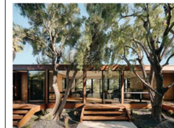
**Entrée.** La maison rectangulaire de plain-pied repose sur des fondations en blocs de béton avec des bases vitrées des deux côtés et une ossature en bois de séquoia.
